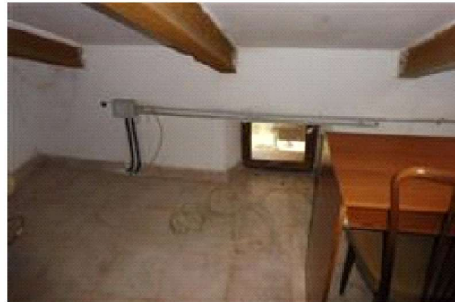
Interno P2 - sottotetto
